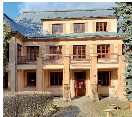
BD Hajnice – soc. rehabilitace, Oranžová kavárna, Trutnov
